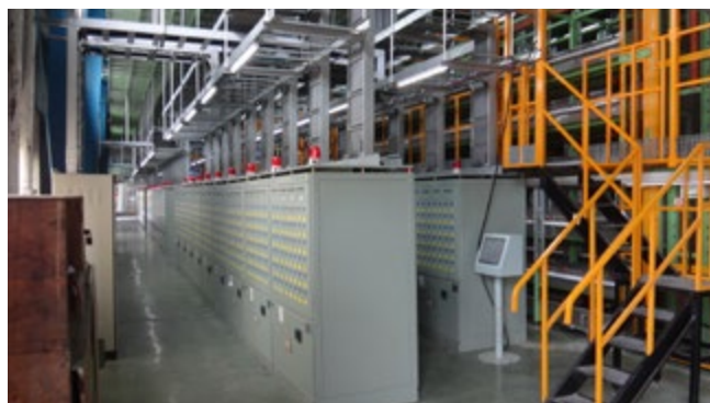
新たに構築された製造ライン
