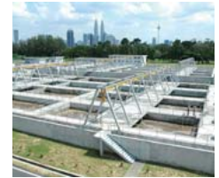
日立プラントテクノロジーが建設したマレーシアの下水処理場
