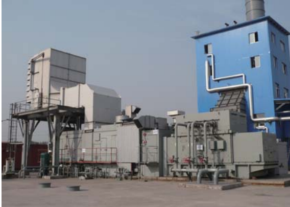
ガスタービンH-25を採用した中国の清徐県景源熱電 (Jingyuan Redian) 有限公司のコージェネレーション発電設備
