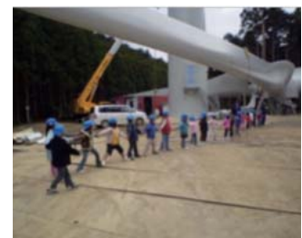
小学生が風力発電設備の 現地据付工事を見学
