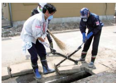
津波で道路の側溝にたまった泥の撤去作業
