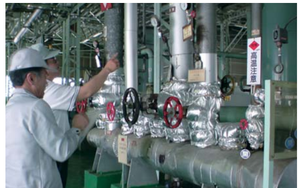
現場での省エネ診断
