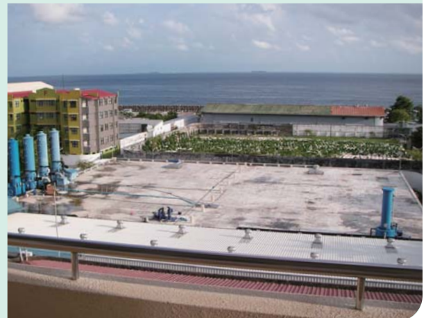
モルディブ共和国での上下水道運営事業の施設
