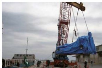
地割れした構内の道路（左上）。倒れた工場建屋内の空調設備（左下）。工場内で発電機の組立作業を再開（右上）。日立港から、震災後初めて出荷されるガスタービン（右下）
