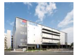
日立物流のセキュリティ設備を完備した物流センター「京浜物流センター」
