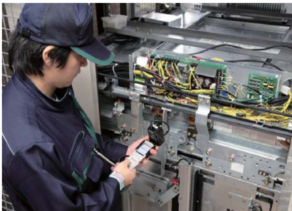
エレベーター制御盤の保守作業
