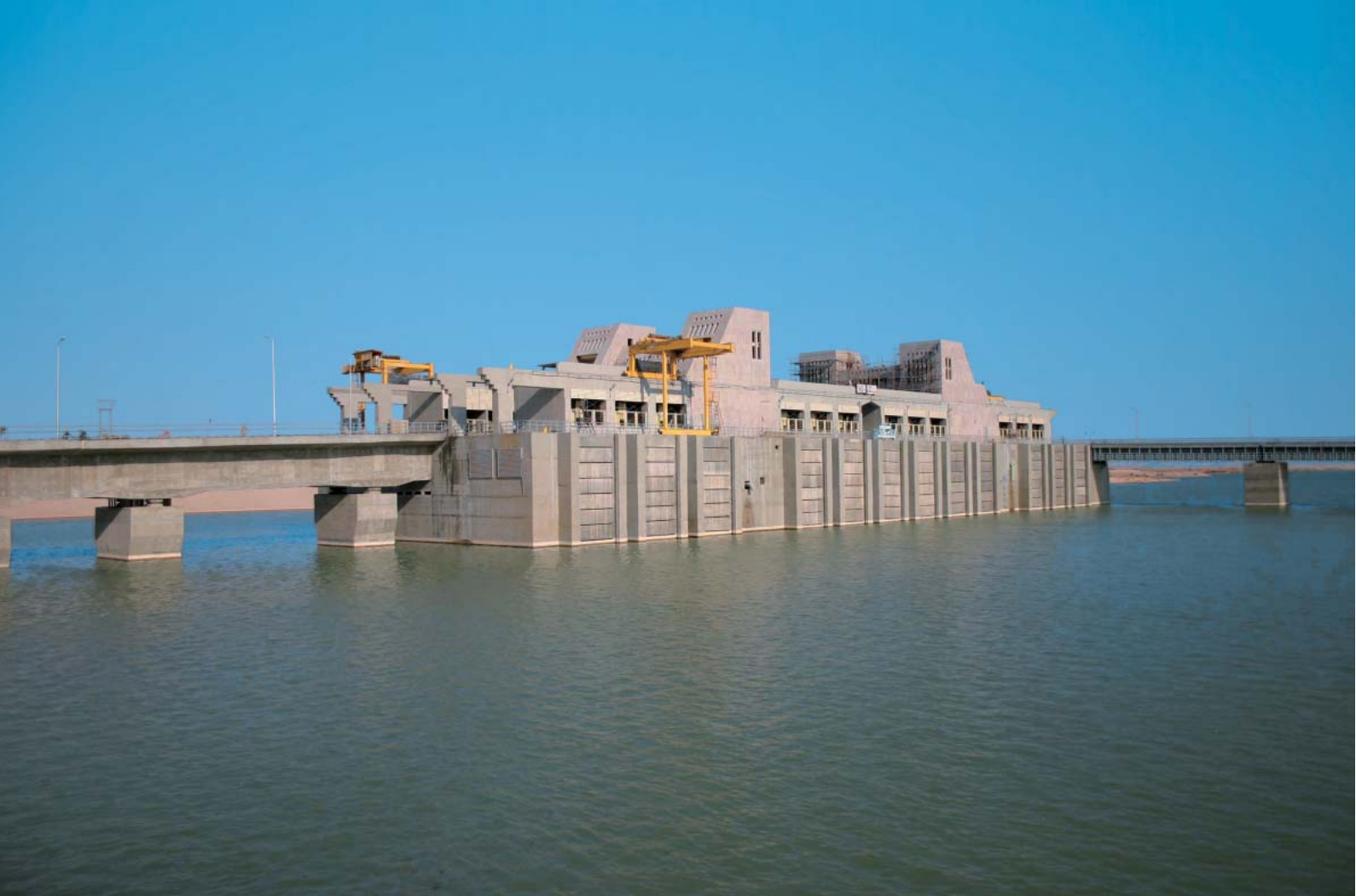
ムバラクポンプ場全景
