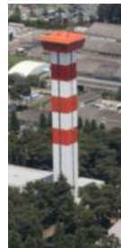
1967年 エレベーター研究塔(90m)
