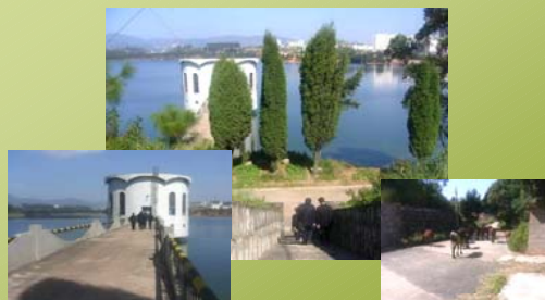
化学プラント、排ガスファン/工水取水ポンプ場
