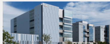
岡山データセンター
